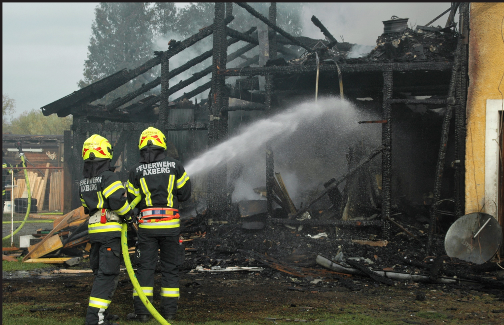
Angriffstrupp beim Löschen mit einem C-Rohr
